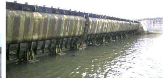
洪水吐ゲート (下流より望む)
